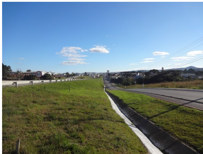
Figura 71: Travessia Urbana de Lages - Vias marginais implantadas
