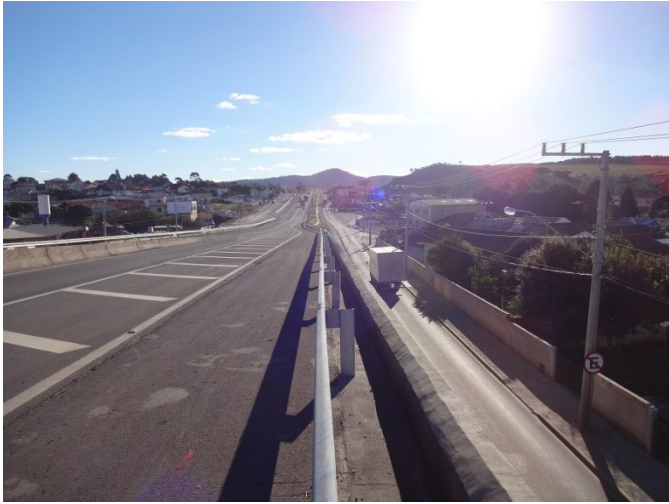
Figura 73: Um dos cinco viadutos previstos
