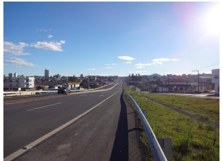
Figura 72: Vista global da travessia concluída
