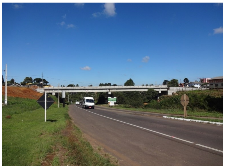
Figura 58: Obras do Viaduto em Catanduvas (Obra extra CREMA)
