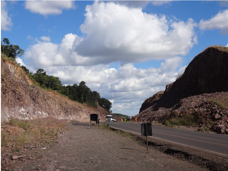
Figura 9: Corte em rocha no km 89,0
