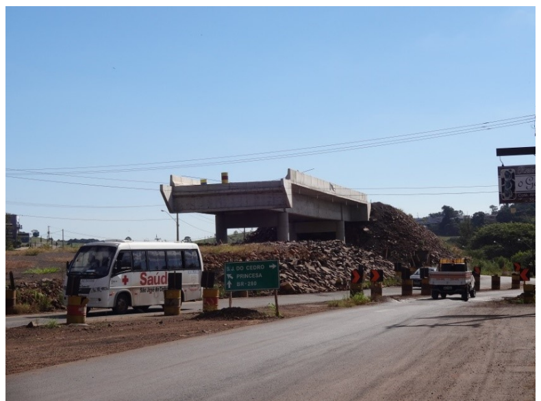
Figura 5: Viaduto aguardando aterro das cabeceiras, em São José do Cedro
