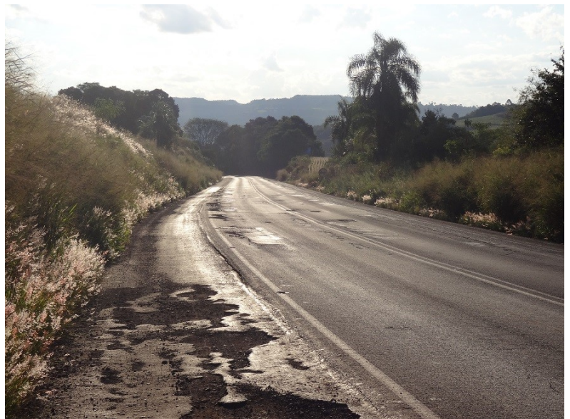
Figura 36 BR-282/SC- Trecho próximo ao Frigorífico da Aurora – Pinhalzinho- Buracos e deformações graves no acostamento e na pista de rolamento
