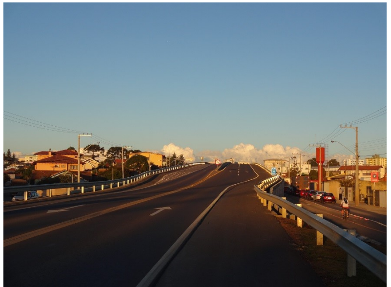
Figura 75: Viaduto concluído no km 219
