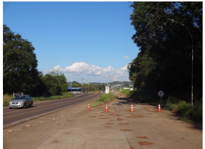
Figura 42: Acesso abandonado do Posto de Pesagem de Maravilha
