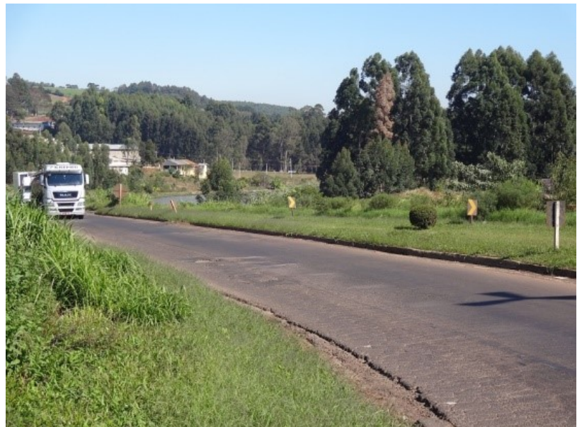
Figura 21: Buracos e afundamentos no acesso a Xaxim- km 521
