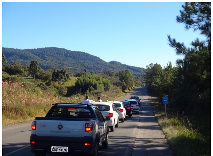
Figura 69: Obras de drenagens profundas no km 170
