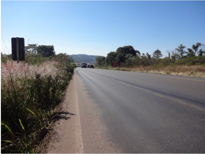
Figura 19: Km 507 da BR-282/SC- Terceira faixa formando trilhas de roda
