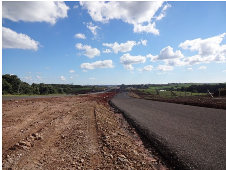
Figura 17: Obras do Contorno de Xanxerê, na BR-282/SC
