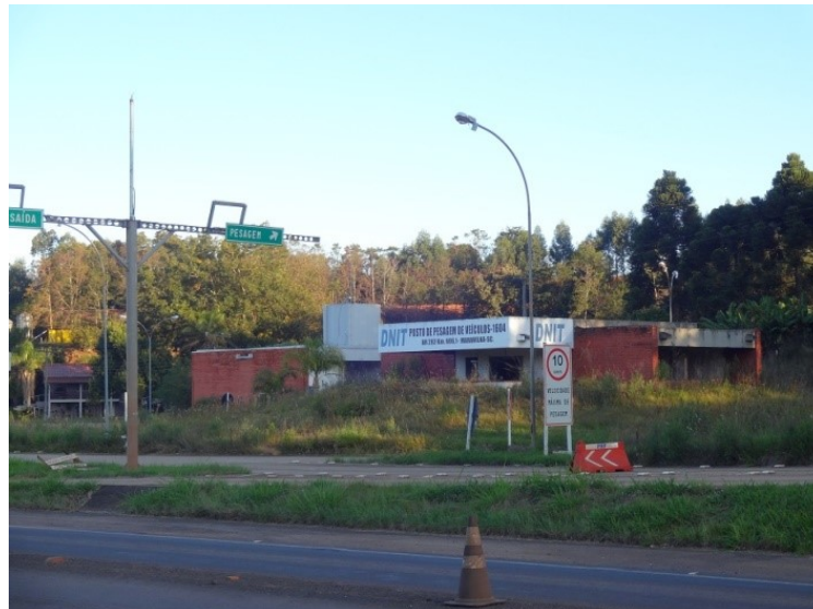
Figura 41: Situação de abandono do Posto de Pesagem do DNIT- Maravilha
