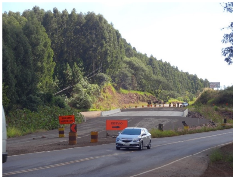
Figura 4: BR-163/SC - Viaduto no km 99,0
