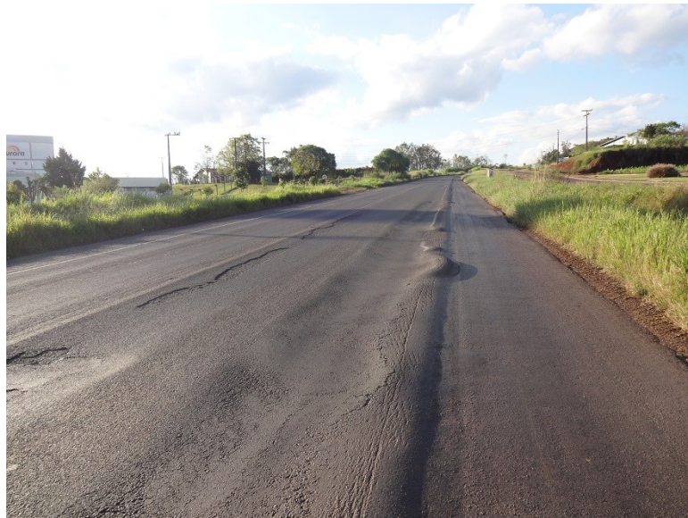
Figura 38: BR-282/SC, em frente ao Frigorífico Aurora- Pinhalzinho. Trilha de roda
