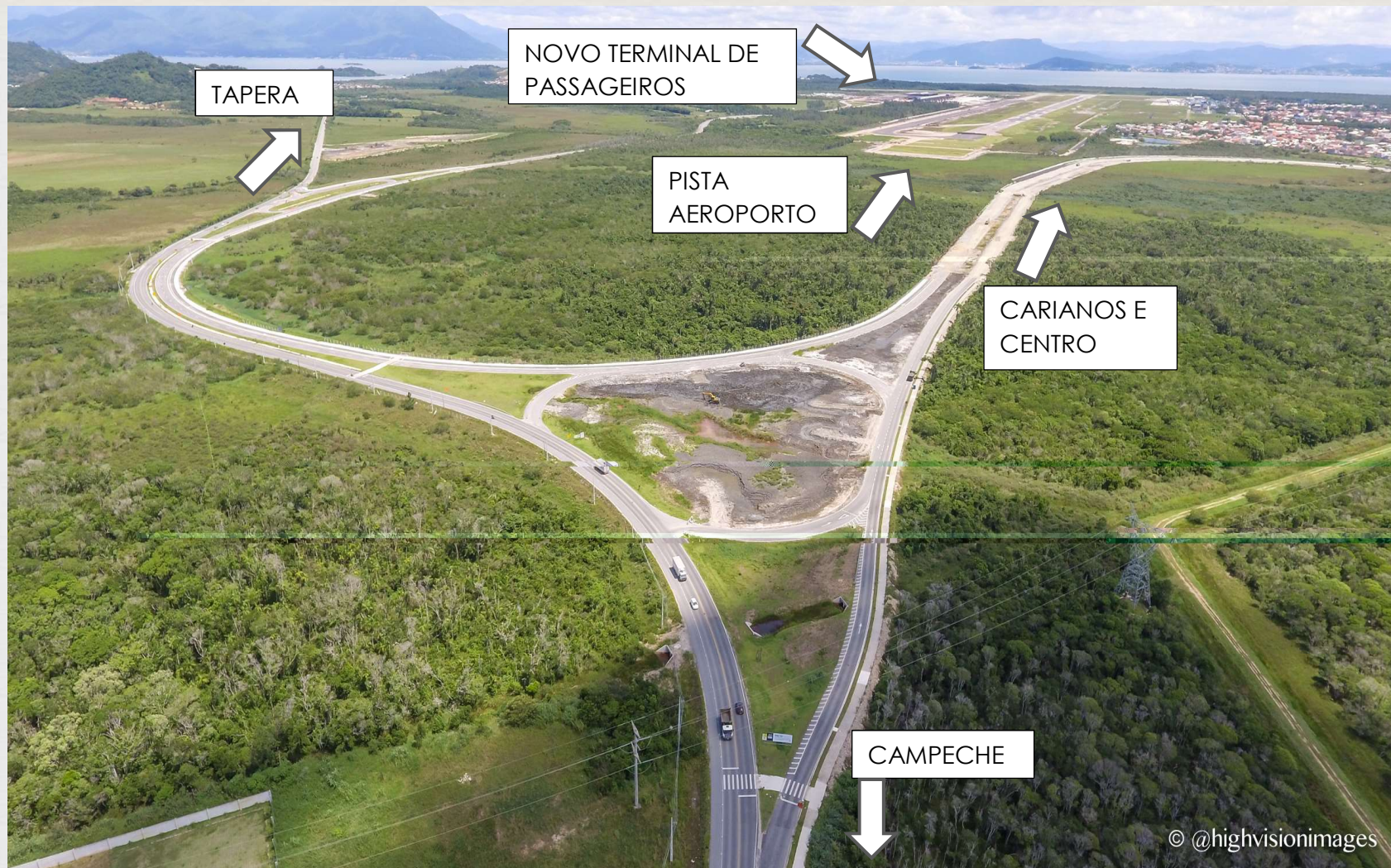
Interseção Centro/ Campeche/ Tapera/ Novo Terminal de Passageiros do Aeroporto Internacional de Florianópolis.
