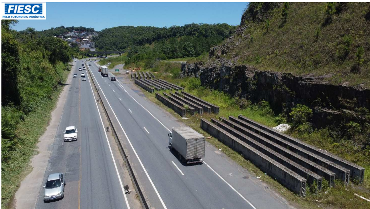
29: VIGAS PRÉ FABRICADAS DEPOSITADAS NO KM 50
