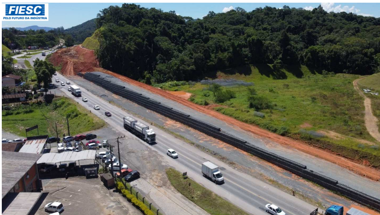
34: MUROS DE CONTENÇÕES - GABIÕES - EM EXECUÇÃO NO KM 54,6
