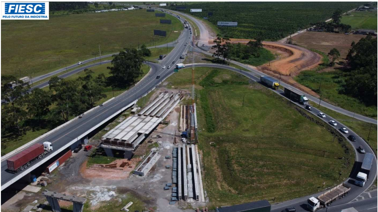
8: OBRAS DO VIADUTO NO KM 7,3 - SOBRE A BR-101/SC, INCLUSIVE ALÇAS DE ACESSO
