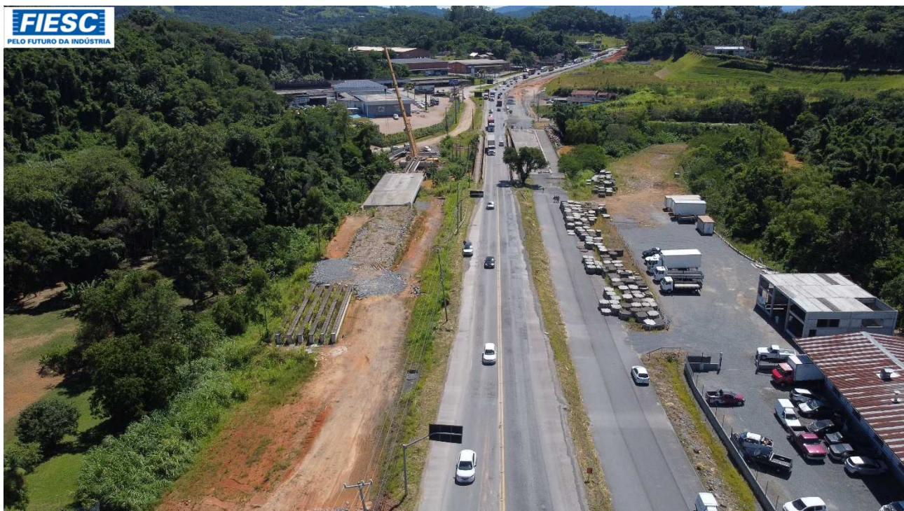
39: OUTRA VISTA DAS OBRAS DA PONTE SOBRE O RIO BENEDITO, EM INDAIAL.
