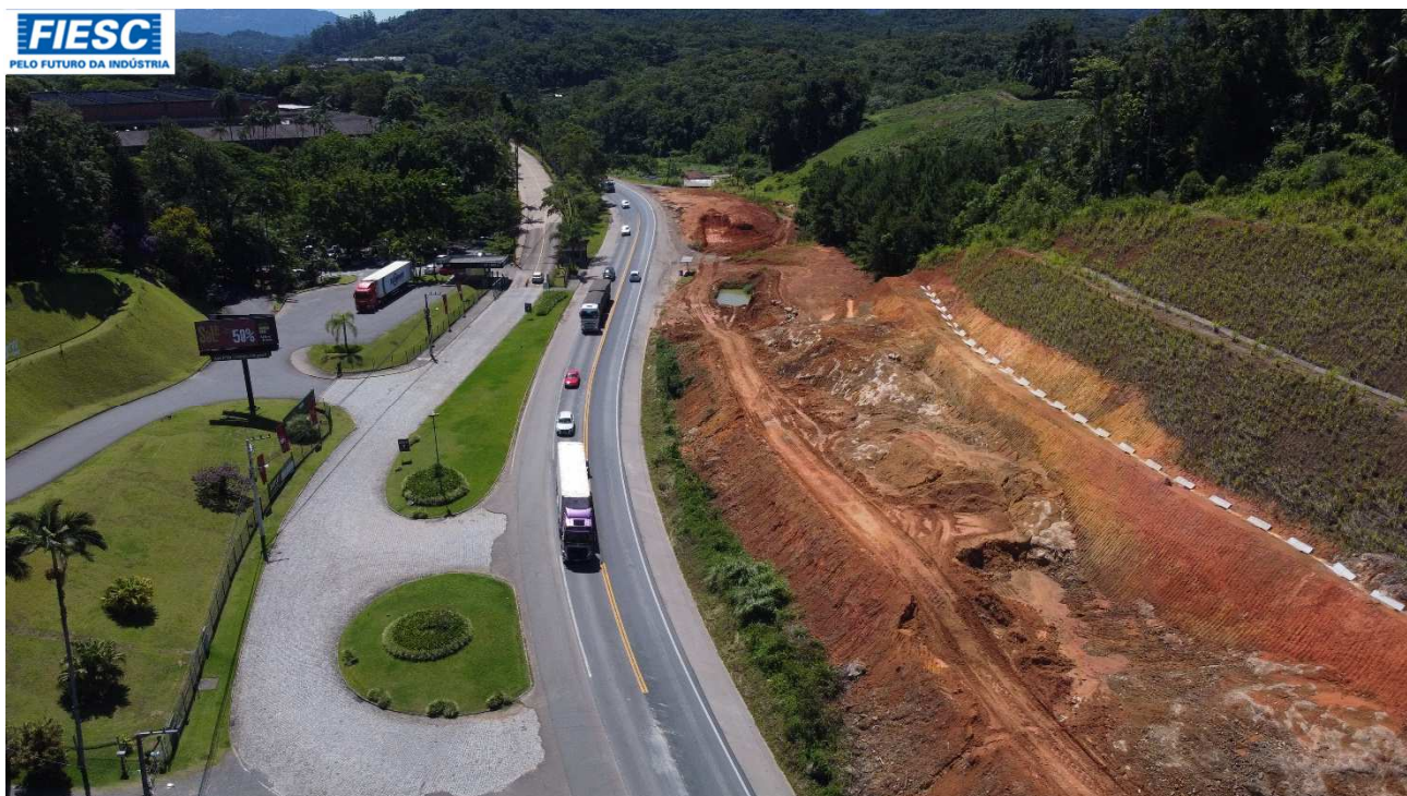
33: TERRAPLENAGEM E CONTENÇÕES DE ENCOSTAS - KM 54
