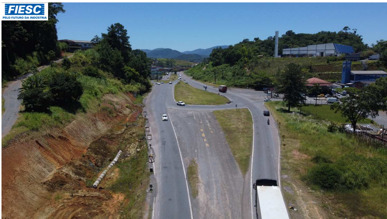
31: LOCAL DO FUTURO VIADUTO NO KM 52,6 - NÃO INICIADO
