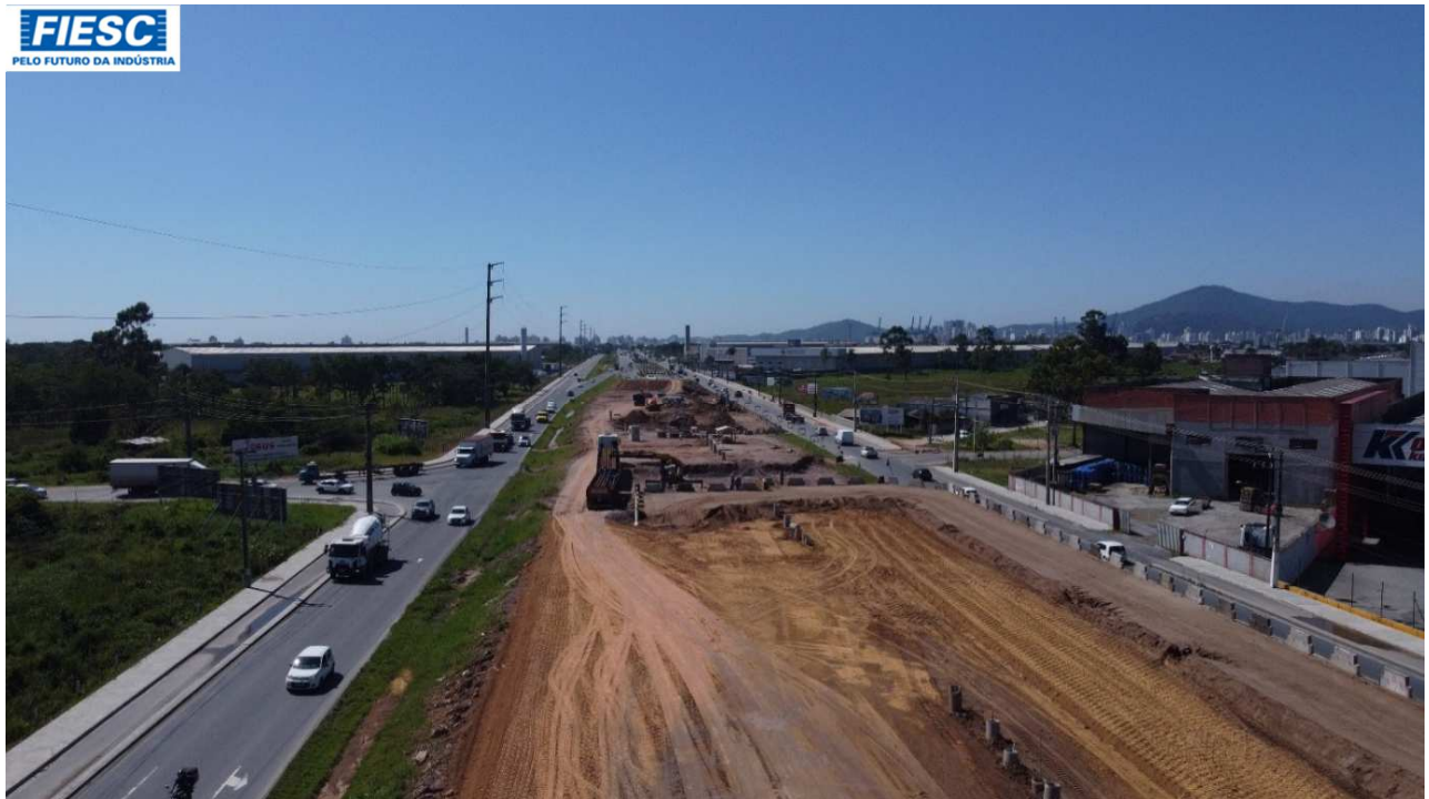
3: OBRAS EM EXECUÇÃO PARA EDIFICAÇÃO DO VIADUTO - KM 1,9
