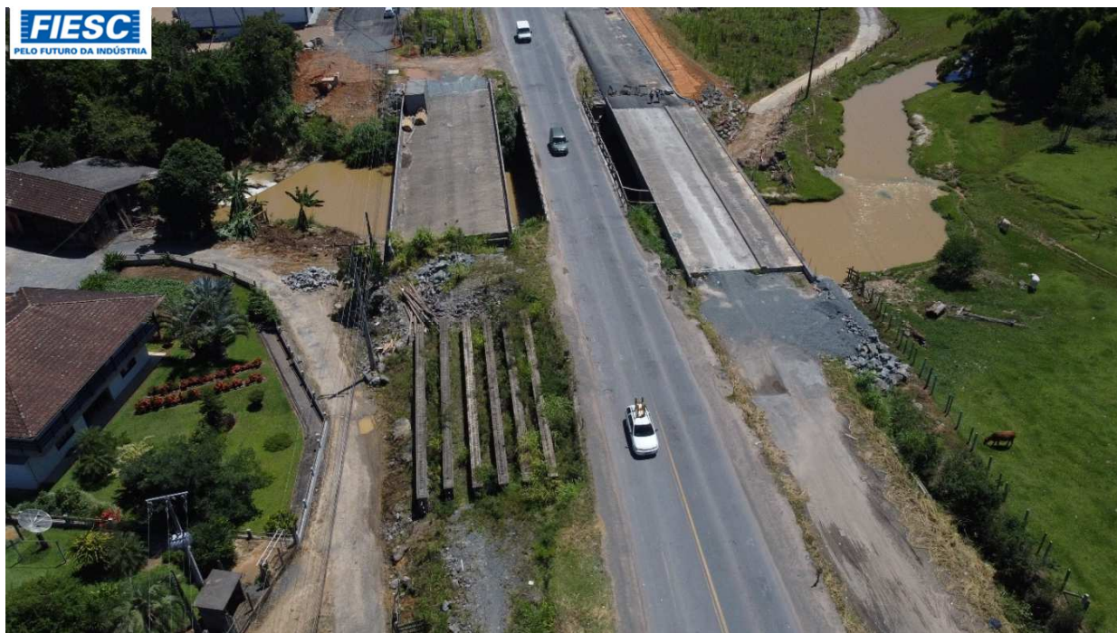
36: PONTES EM EXECUÇÃO SOBRE O RIBEIRÃO ESTRADINHA
