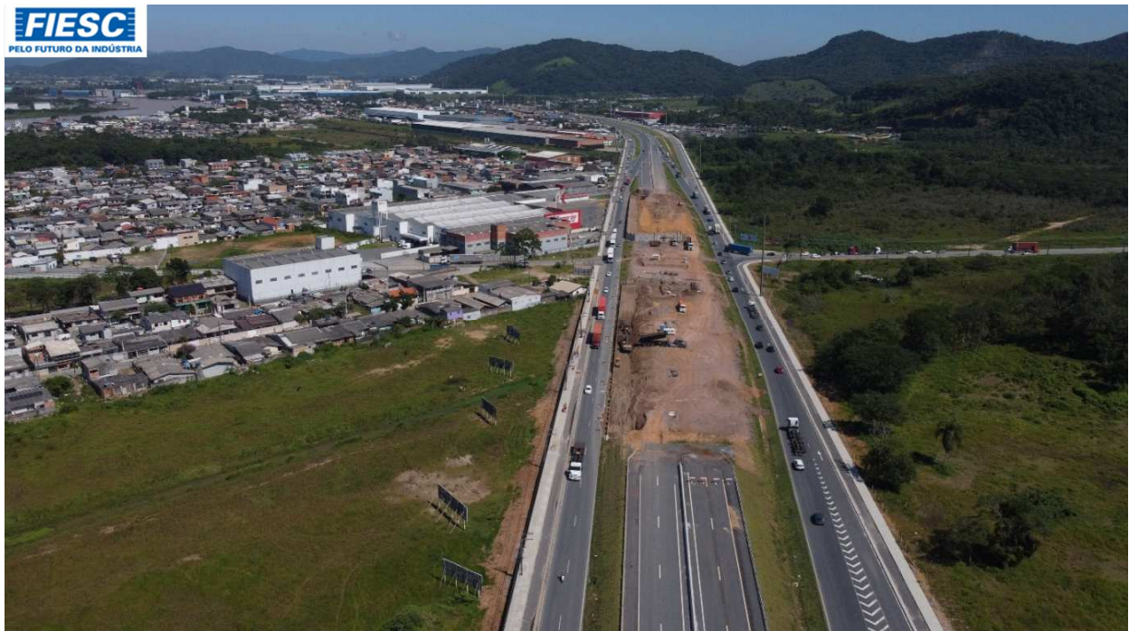
4: EXECUÇÕES DE ENCONTROS EM TERRA ARMADA E DO VIADUTO - KM 2,0
