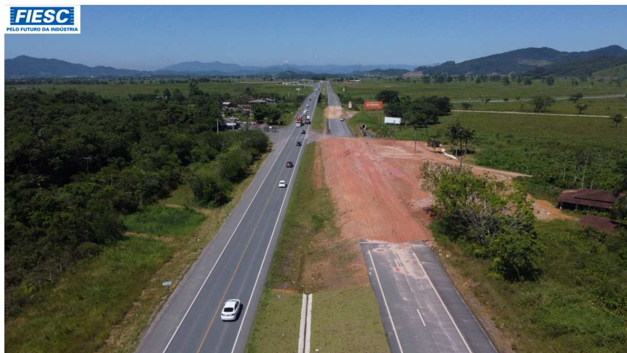
10: OBRAS DE SOBRE CARGA PARA ADENSAMENTO DO SUBLEITO - KM 8,7
