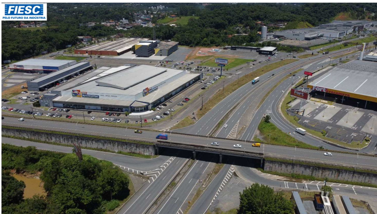
30: VIADUTO NA INTERSEÇÃO COM A SC-108 - KM 51
