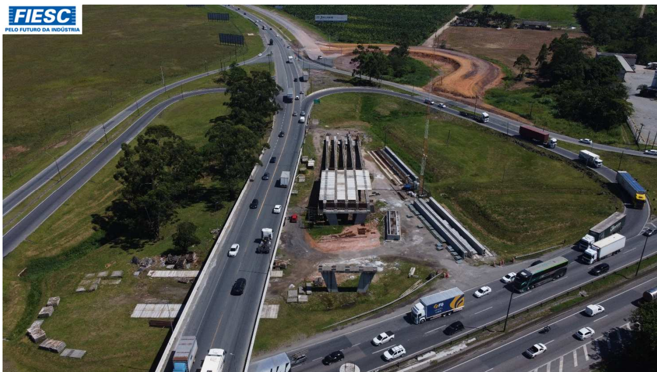
9: OUTRA VISTA DAS OBRAS DO VIADUTO - KM 7,3
