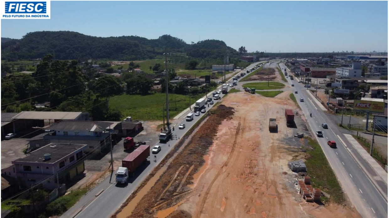
7: OUTRA IMAGEM DAS OBRAS NO VIADUTO DO KM 3,8
