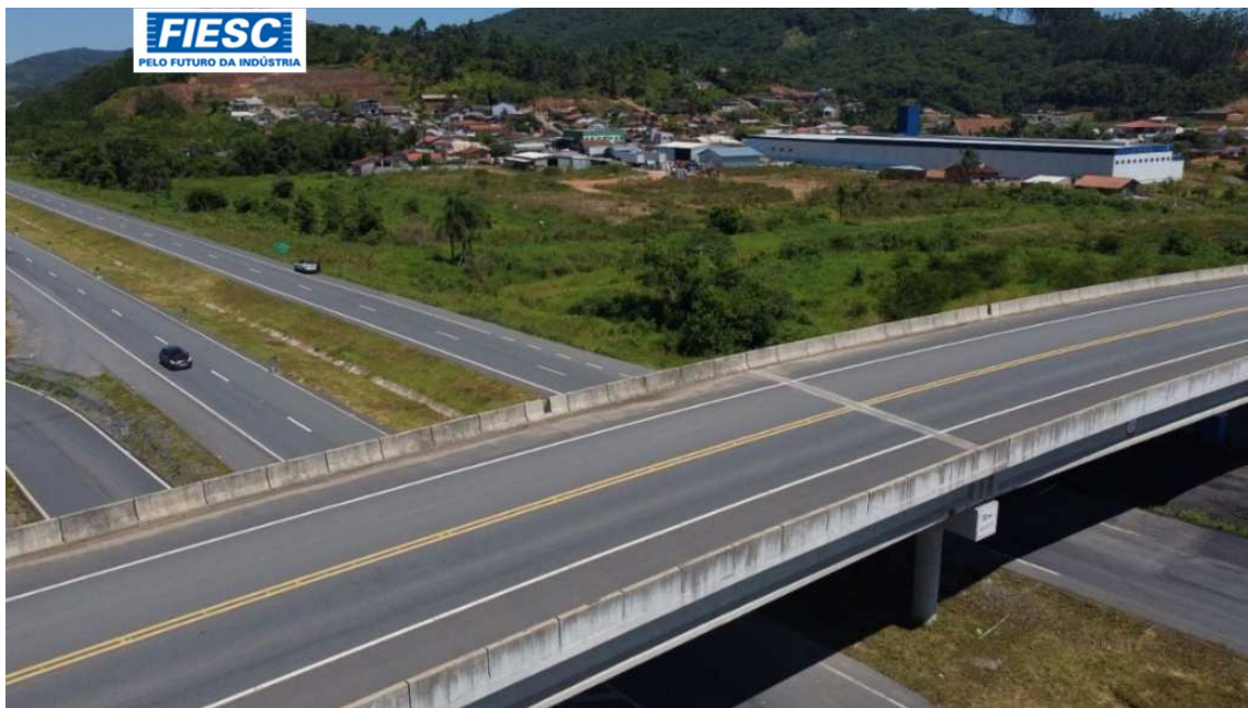
12: VIADUTO NO KM 22 - ACESSO À ILHOTA
