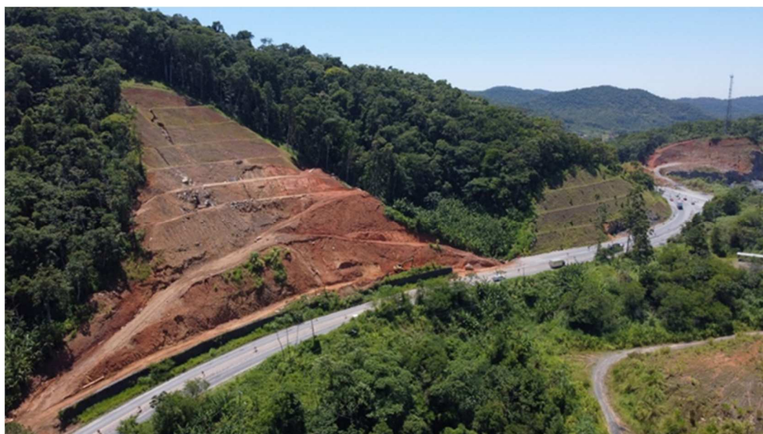
21: OUTRA VISTA DO CORTE EM EXECUÇÃO, COM PROTEÇÃO DAS ENCOSTAS
