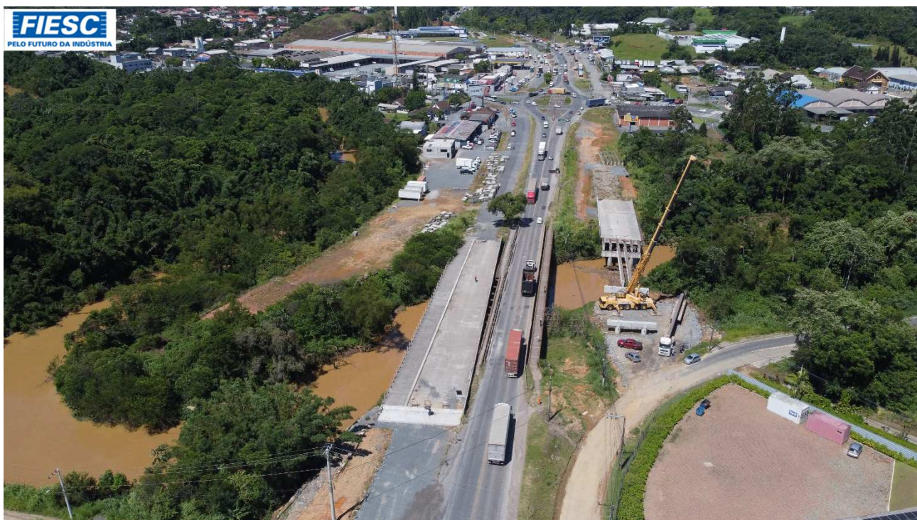
38: PONTES EM EXECUÇÃO SOBRE O RIO BENEDITO
