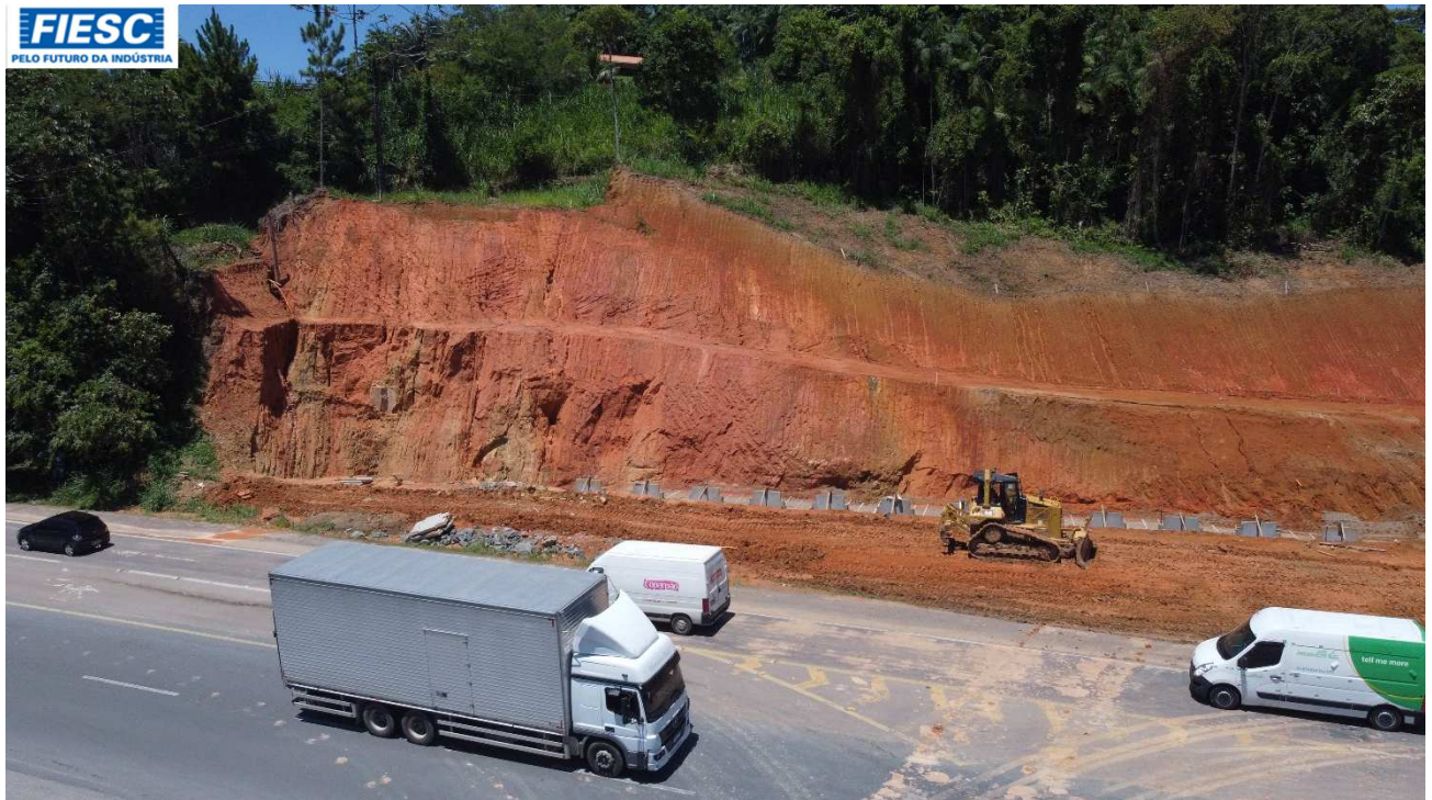
24: MURO DE CONTENÇÃO, EM TERRA ARMADA, EM EXECUÇÃO - KM 45,1
