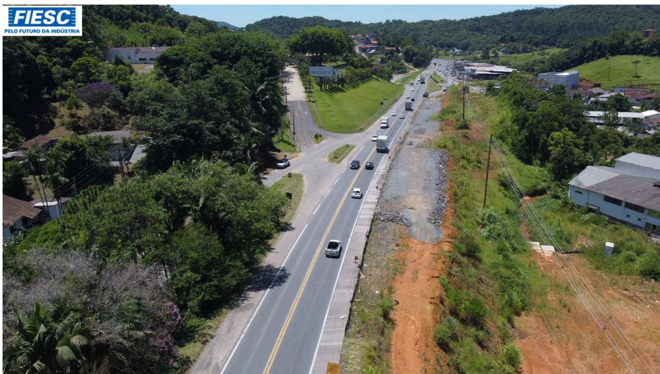
28: OBRAS DE IMPLANTAÇÃO E PAVIMENTAÇÃO DA NOVA PISTA - KM 47,8
