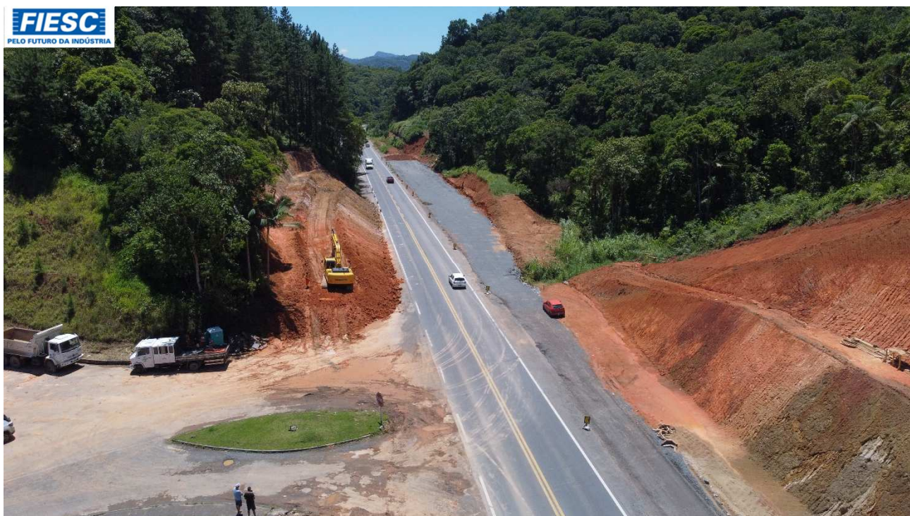
26: OBRAS DE TERRAPLENAGEM - KM 46
