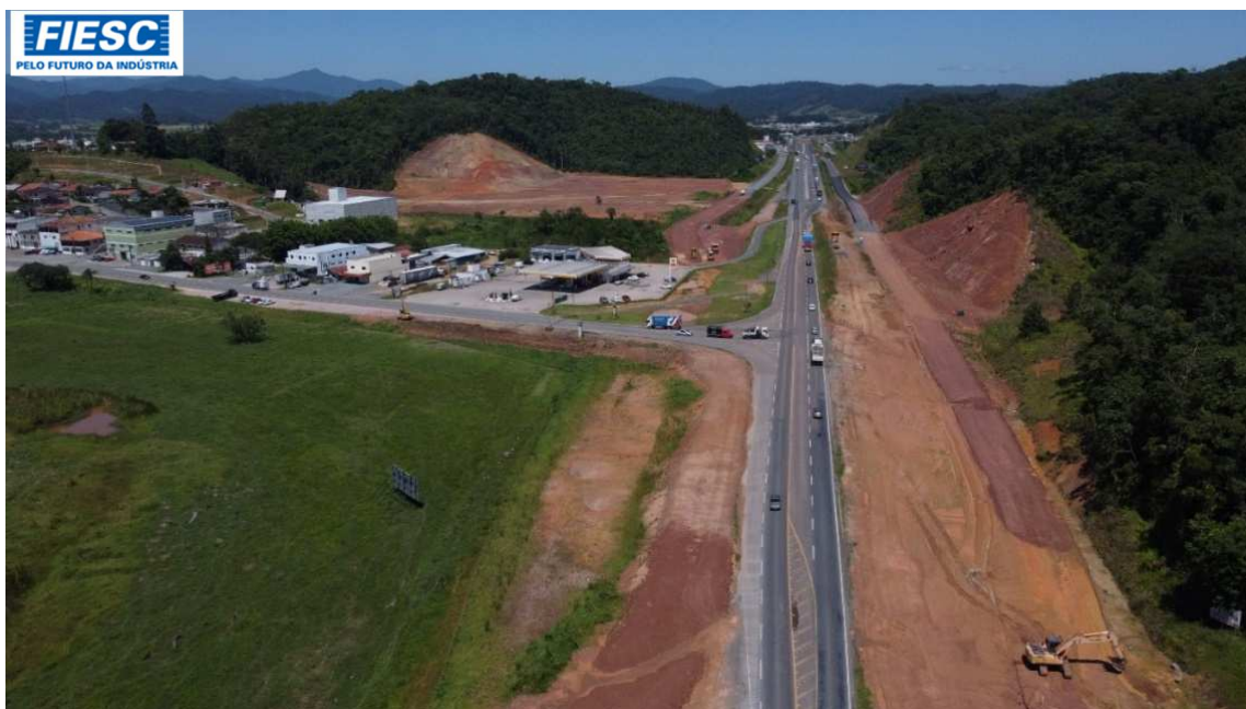
13: VIADUTO À SER EXECUTADO NO ACESSO À CIDADE DE GASPAR - KM 35
