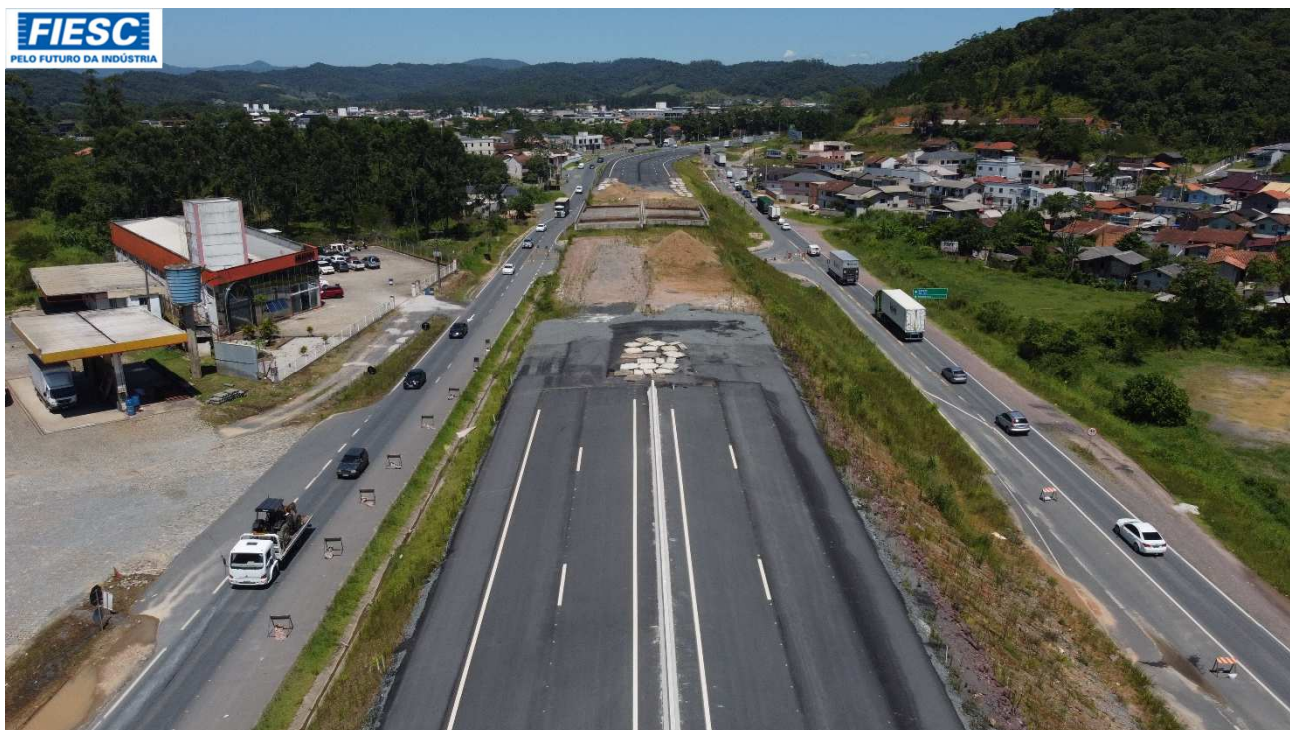
17: OUTRA VISTA DO VIADUTO NO KM 36,2
