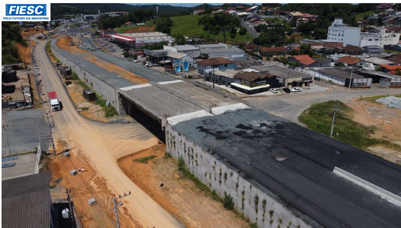
37: VIADUTO EM FASE FINAL DE EXECUÇÃO NO KM 64,5, EM INDAIAL
